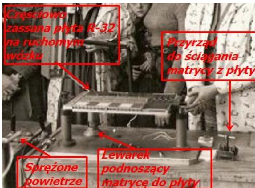
Fot. Częściowe oprzyrządowanie stanowiska zasysania
